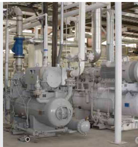
De snelheidsregeling van de hoofdcompressor plus een extra compressor zorgt voor verbeterde en gestroomlijnde ontwerp-mogelijkheden en een betere keuze van het compressorformaat voor aanpassing aan uiteenlopende 60Hz-belastingomstandigheden
